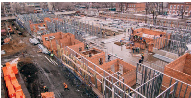
Рис. 3. Возведение многофункционального медицинского центра на 60 мест в г. Усурийске: панельно-каркасное здание со встроенными кирпичными перегородками (фото из статьи [9])
