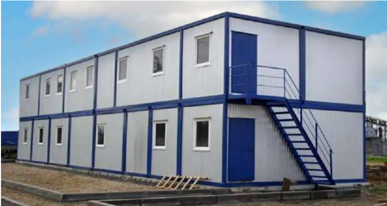
Рис. 5. Модульное здание на базе использования морских сухогрузных блок-контейнеров
