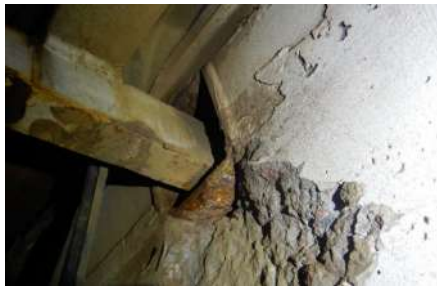
Рис. 1. Скол бетона под траверсным коробом, заделанным в шкафную стенку устоя
