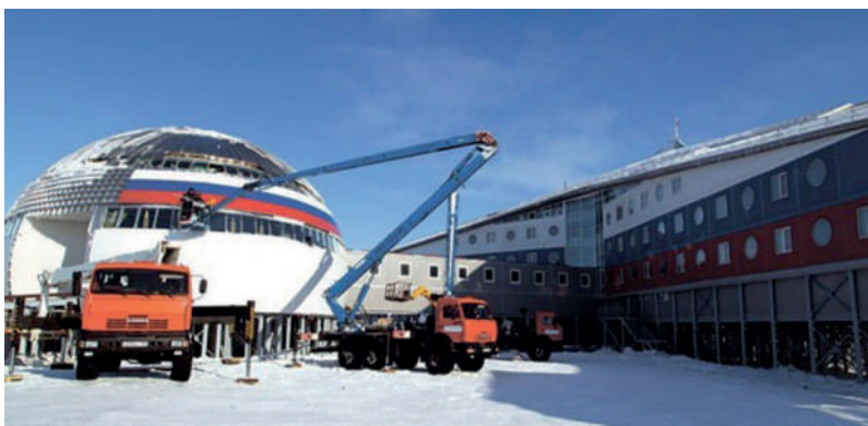
Рис. 2. Монтаж ограждающих конструкций (сэндвич-панели) одного из зданий комплекса «Арктический Трилистник»
