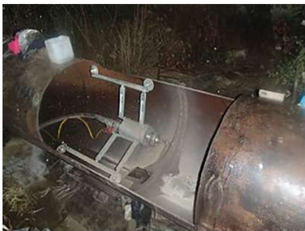
Рис. 2. Нанесение полимерцементного покрытия
