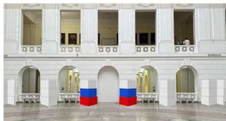
Рис. 5. Объемные звукопоглощающие элементы в атриуме ЮРГПУ (НПИ) им. М. И. Платова
