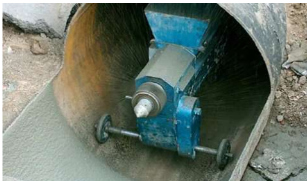
Рис. 1. Нанесение цементно-песчаного покрытия
