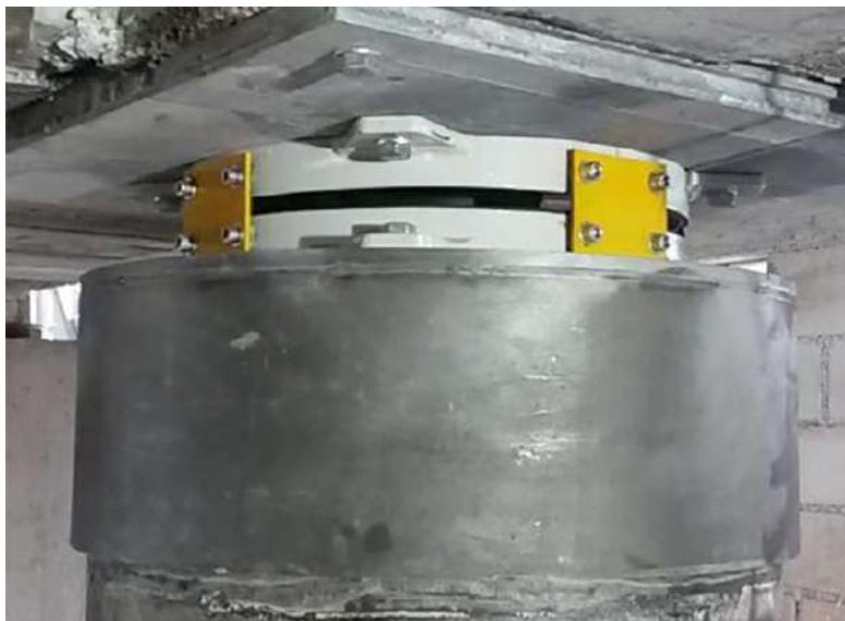
Рис. 6. Вариант крепления к стальной надземной конструкции
