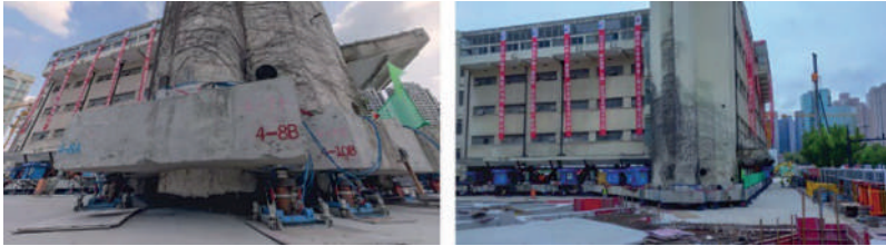
Рис. 3. Процесс перемещения 5-этажной школы в Шанхае по технологии «walking machine». Источник – [10]
