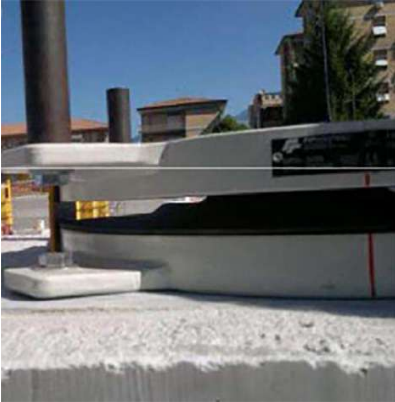
Рис. 3. Изолятор прикреплён к нижней закладной пластине
