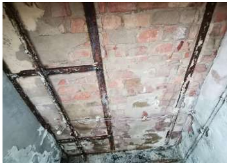
Рис. 1. Перекрытие Клейна. Производственное здание, г. Калининград
