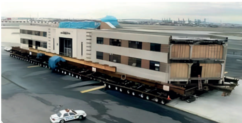
Рис. 1. Процесс перемещения центральной секции терминала аэропорта Ньюарк, США. Источник – [7]
