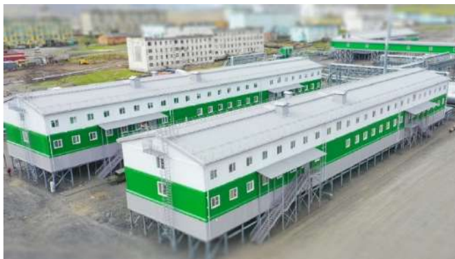
Рис. 4. Военно-строительный комплекс с применением модульных технологий для военнослужащих ракетно-зенитного комплекса ПВО в посёлке Тикси, Республика Саха (Якутия)
