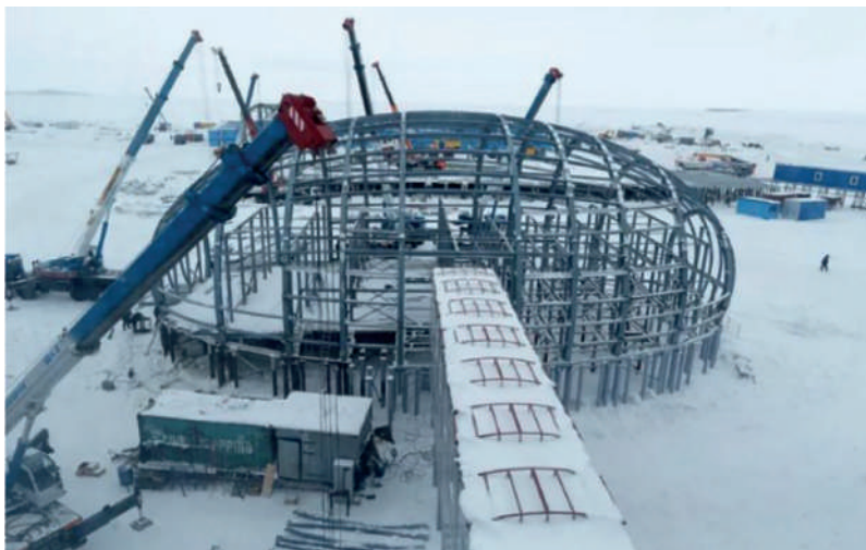
Рис. 1. Строительство несущего каркаса объекта в составе комплекса «Арктический Трилистник»
